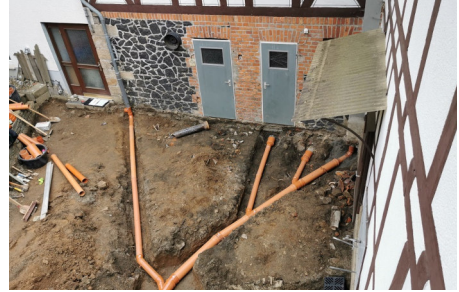
Die ersten Rohre liegen
