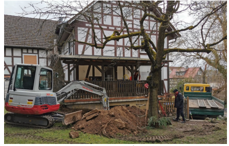
Der Bagger rückt an...
